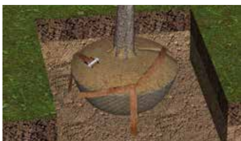
Verbind de 3 ankerbanden met 1 gordel inclusief ratel
